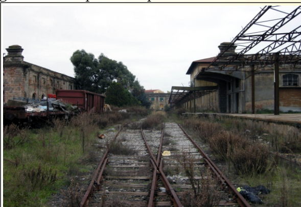
vista dell'interno della stazione foto di Luca Pasquini 2008
